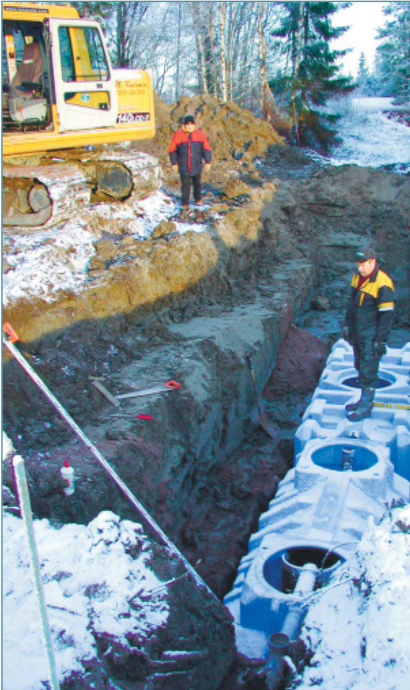
Pubdistamon toiminnan ja käyttöään kannalta asennusvaihe on tärkeä työvaihe.
