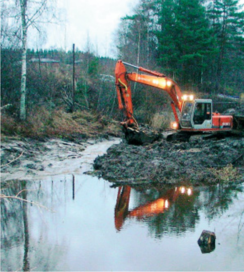
Imponojan kosteikon kunnostustyömaa.
